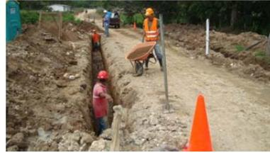
Contempla la construcción de una red de alcantarillado sanitario de 1.6 km, diámetros de 6" y 8". Colector de 1.62 km de tubería de 10", un tratamiento que contiene desarenador, rejilla, dos lagunas facultativas, dos lagunas de maduración, obras de entrada, salida, interconexión, distribución y medidas de protección.
