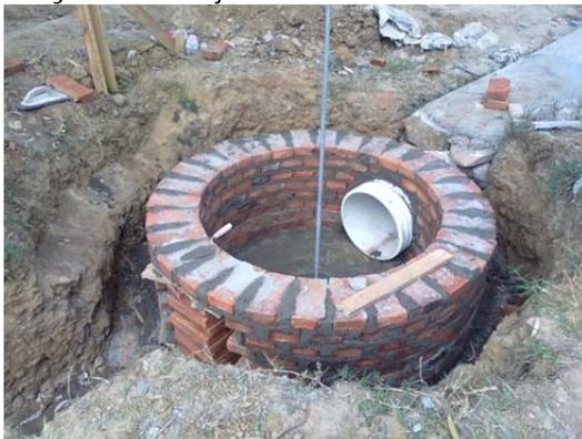
Comprende 475 metros de tubería para el colector principal, 15 pozos de inspección de alturas variables, y obras de tratamiento de aguas residuales: Un desarenador con su respectivo canal Parshall, Para la primera etapa, dos lagunas facultativas cada una de 105.60 metros de largo por 54.60 metros de ancho y una profundidad de 2.20 metros y dos lagunas de maduración de 77.60 metros de largo por 40.60
